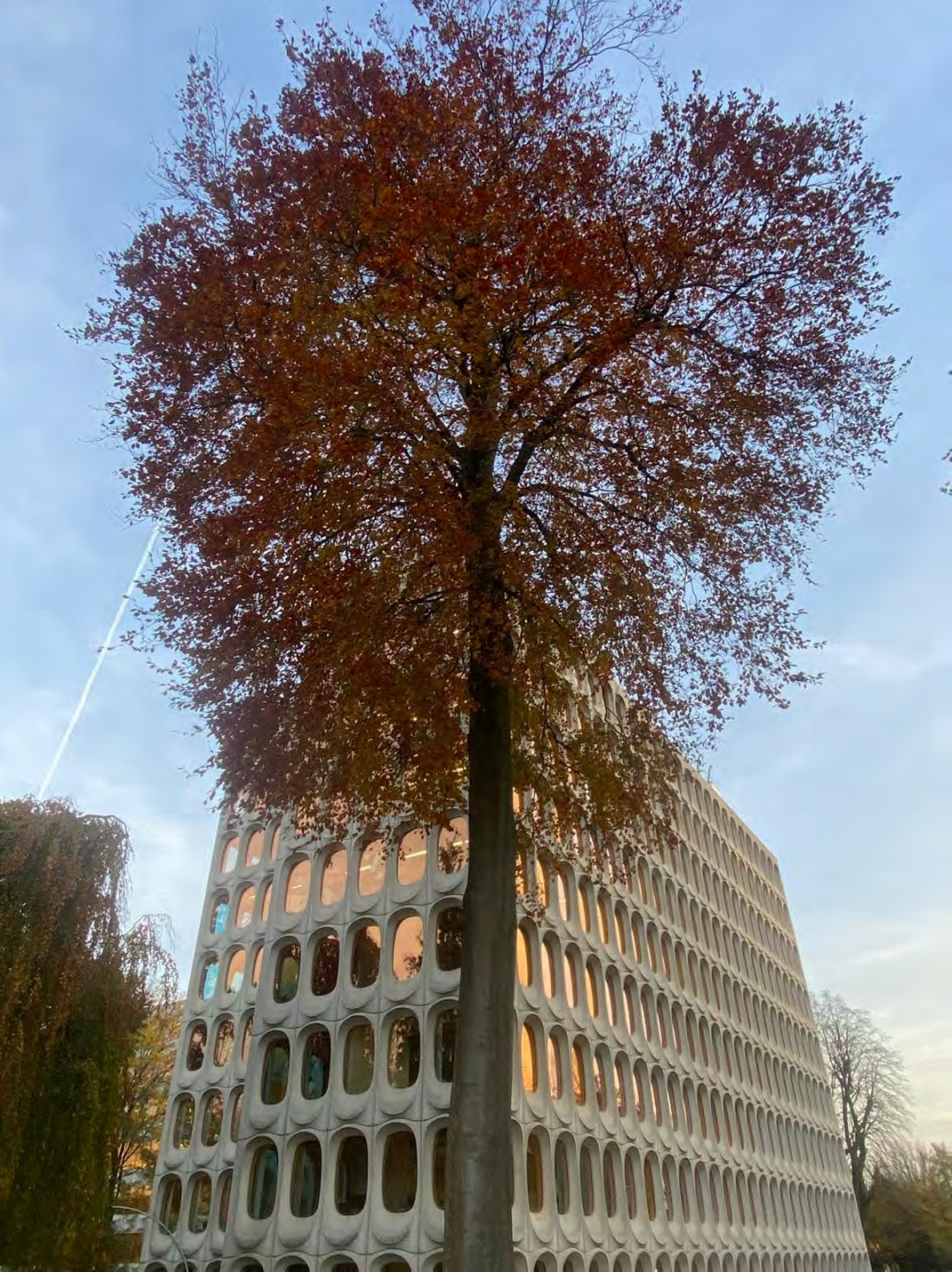
FOXBURY (voorheen C.B.R. gebouw)
