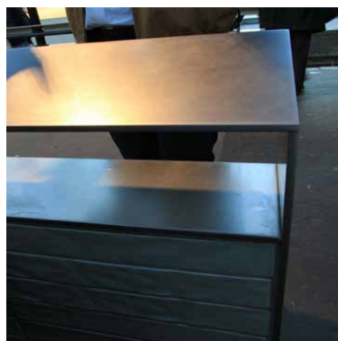
De nieuwe balustrades van de trappen naar het spoor
