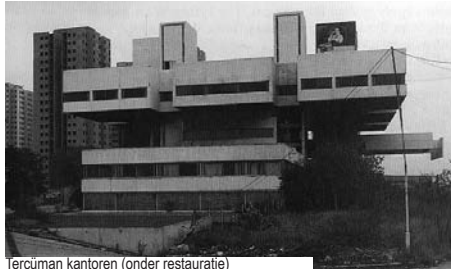
Tercuman kantoren (onder restauratie)
