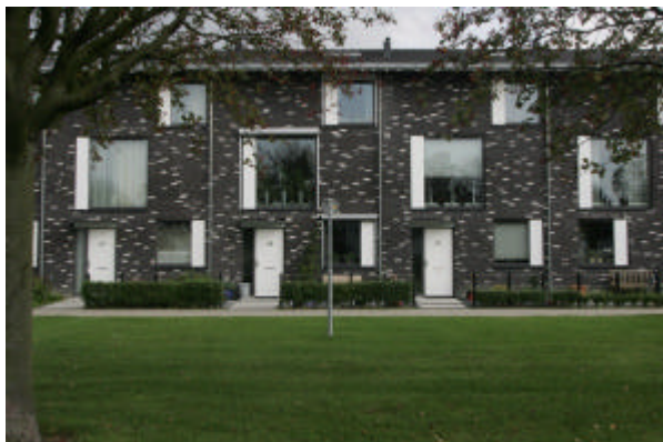
Woningbouw Westerscheldestraat, architect De Zwarte Hond
