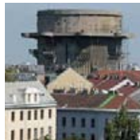
Flugabwehrkanonenturm ('Flakturm') door Friedrich Tamms, 1942-1945
